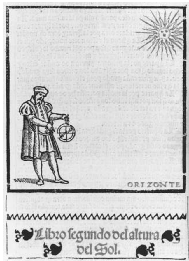
FIG. 20.7. ILLUSTRATION OF A MAN MEASURING A SOLAR ALTITUDE USING A MARINER'S ASTROLABE. Pedro de Medina, Regimie[n]to de nauegacio[n]: Contiene las cosas que los pilotos ha[n] e saber para bien nauegar . . . (Seville: Simon Carpintero, 1563), fol. xv verso. Photograph courtesy of the Beinecke Rare Book and Manuscript Library, Yale University, New Haven.
